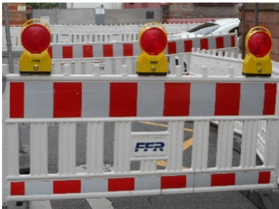
Warnbaken mit Beleuchtung
