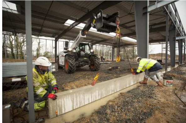
Typische Baustellensituation: Das geländegängige Fahrwerk des Teleskopstaplers ermöglicht Kranarbeiten auch im schwierigen Gelände und bei ungünstiger Witterung (Bobcat).
