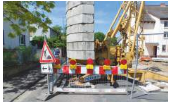
2 | Schlechtes Beispiel: Hier kann problemlos „durchgeschlüpft“ werden.
