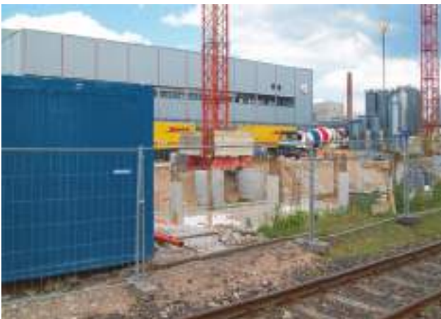
1 | Positives Beispiel einer Absperrung.
